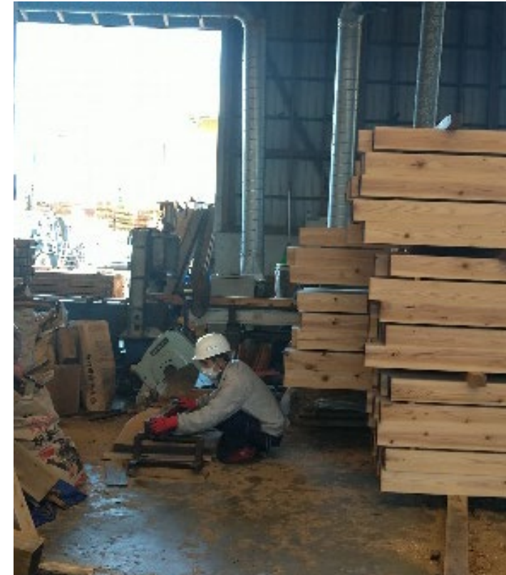
狭い空間での作業
