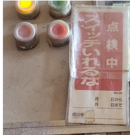
点検作業時の明示
